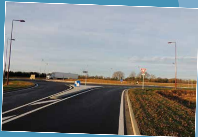
4- Le nouveau giratoire sur la RD 940 en prévision de la création du barreau qui permettra de rejoindre la route d'Encordes.
