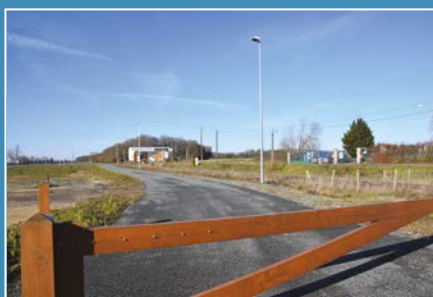
Un parking a été construit à la forge
