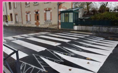
Création d'un plateau surélevé rue des Stuarts afin de sécuriser les enfants de l'école maternelle du printemps et ralentir les véhicules
