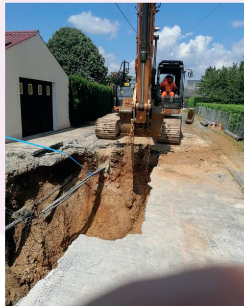
Il s'agit d'élargir la tranchée réalisée pour les travaux d'assainissement afin d'y implanter une canalisation eau potable de diamètre supérieure à celle existante et prévoir les raccordements aux différentes propriétés riveraines.
