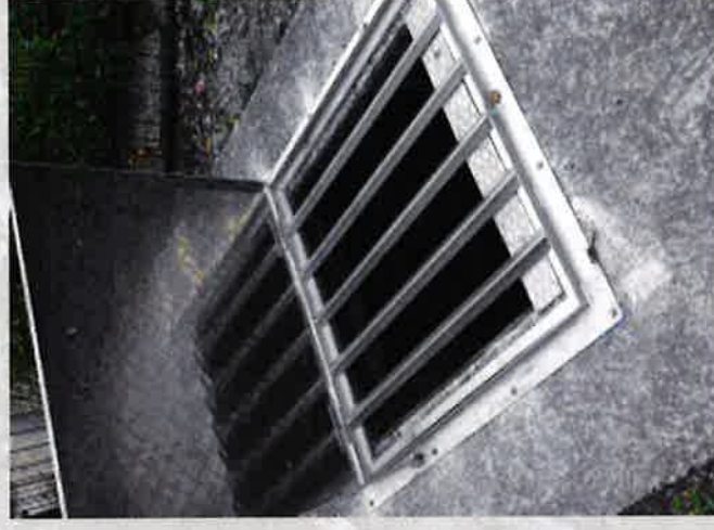
Ancienne dalle à gauche et nouvelle trappe avec barreaudage à gauche
